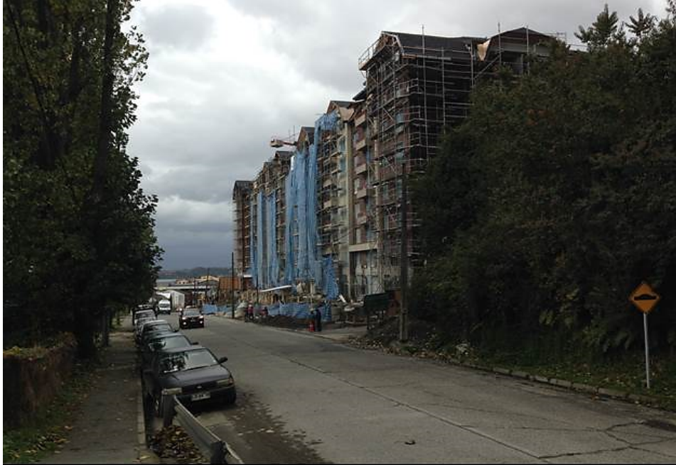
Figura 95. Proyecto en ejecución entre Gramado y Del Salvador
